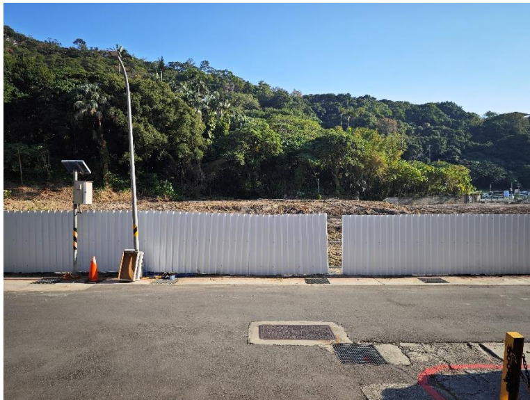
本案為建物拆除後素地，且現場高低落差大，得標廠商須自行辦理整地
