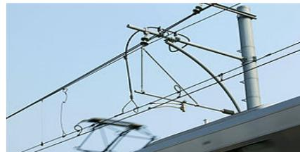
圖 26 強化型架空電車線實體圖
