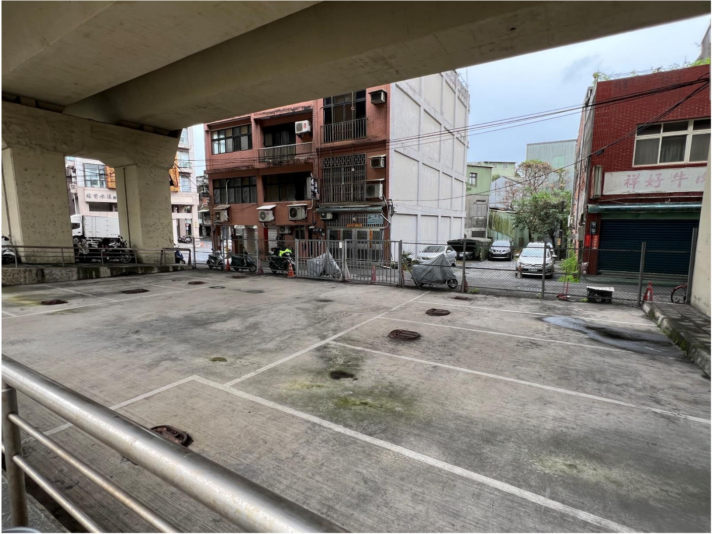
B 標的之三 P124-P201 墩柱間(目前為閒置區域，原多目標設為停車場)
