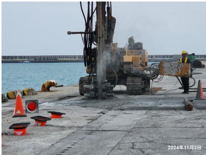
圖 7、微型樁串接工法之施工過程
