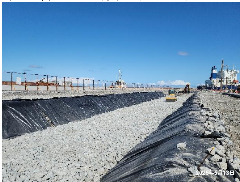
圖 4、織布襯墊全包覆降低透水性及鋪面滾壓
