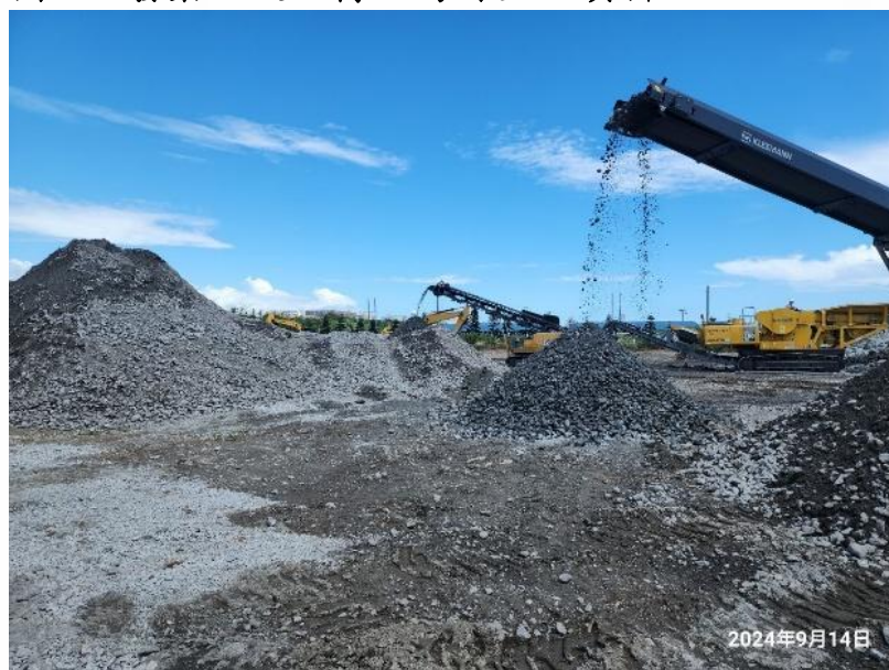
圖 3、廢棄混凝土轉化為再生回填料
