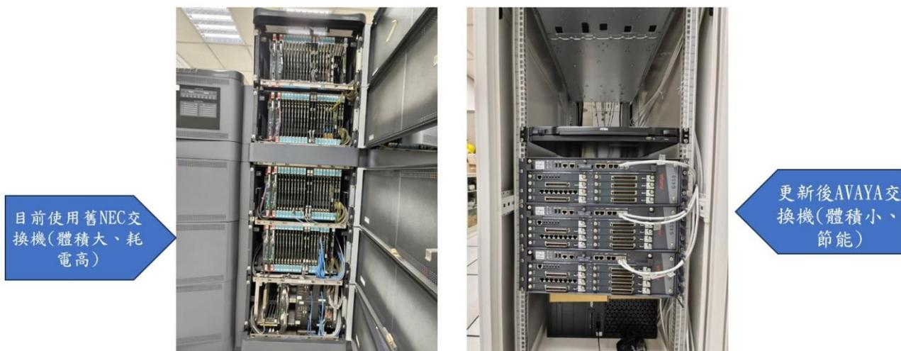
圖四、自動電話系統設備
