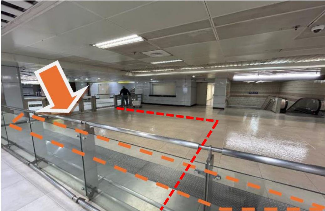
照片 1：管線溝槽（橘色虛線處）
