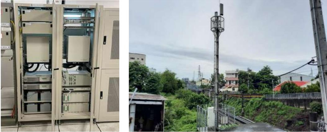
圖 10 室內型中繼站、室外型中繼站及天線鐵塔
