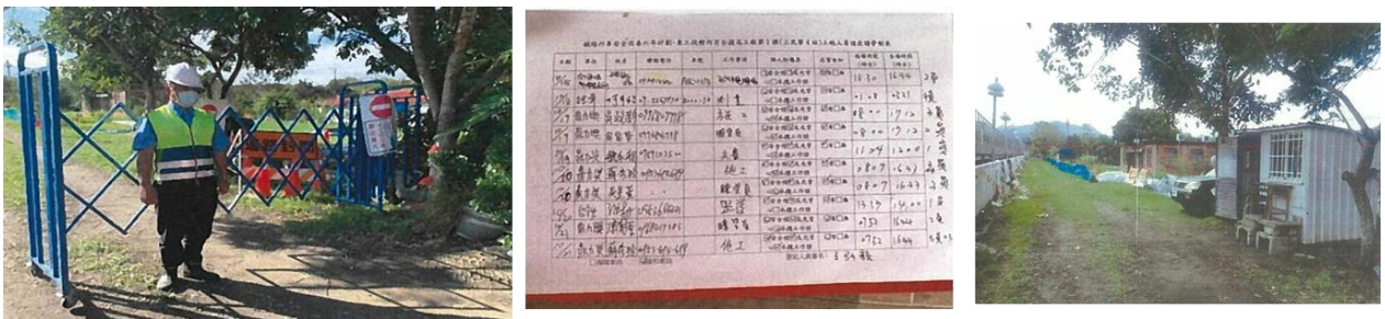
圖 3 臺鐵工地安全管理
