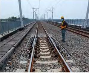
長焊鋼軌兩端為可動區間，需鋪設伸縮接頭
