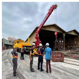
鐵路吊桿車之吊桿承重測試
