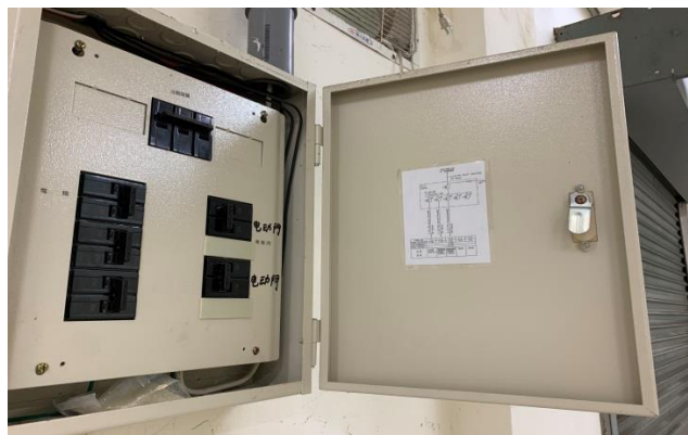
圖 6：「豐原火車站臺鐵3號倉庫」電箱巡檢
