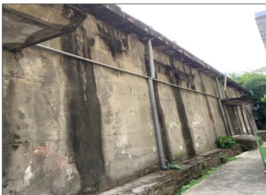
圖 4：「豐原火車站臺鐵3號倉庫」 保養項目之1 牆面
