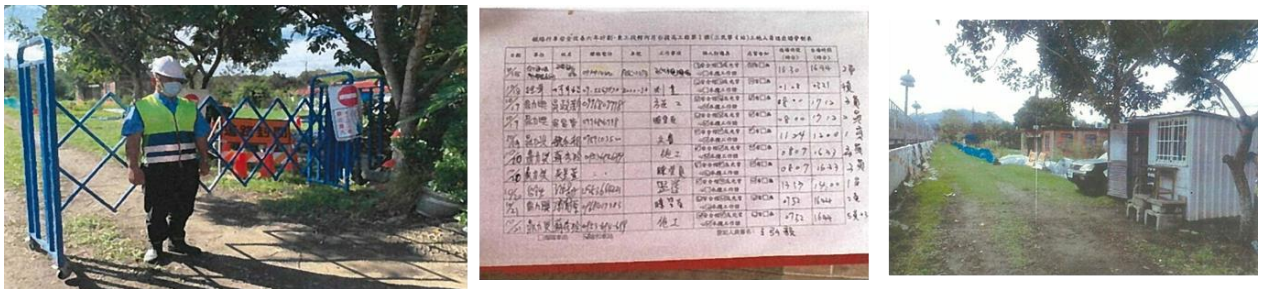
圖 3 臺鐵工地安全管理
