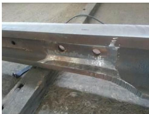
圖 26. 連接板接合面研磨作業
