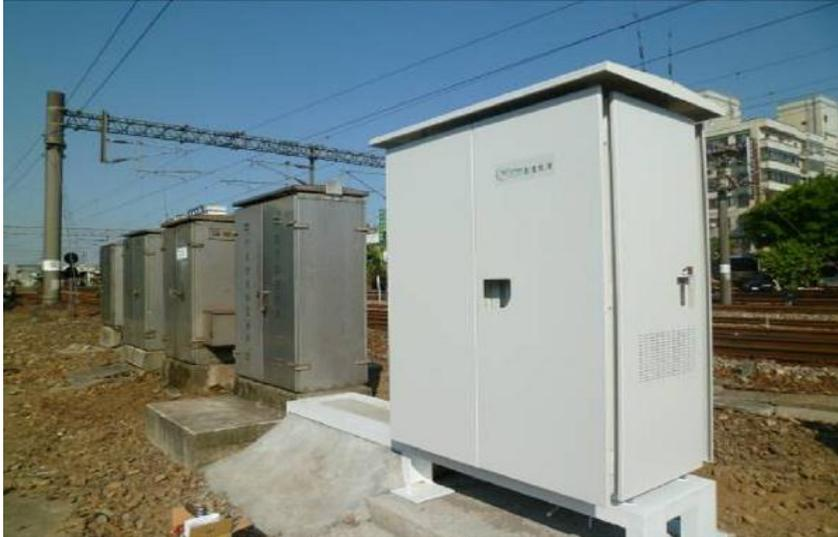
圖 5 台鐵中壢車站號誌之燃料電池備用電力道旁設備箱體
