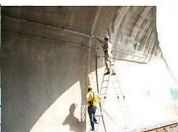
圖 14 隧道漏波電纜設置
