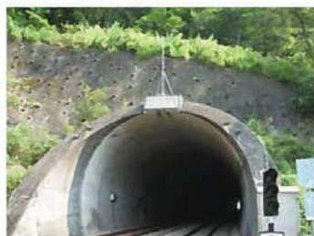
圖 13 隧道口天線設置
