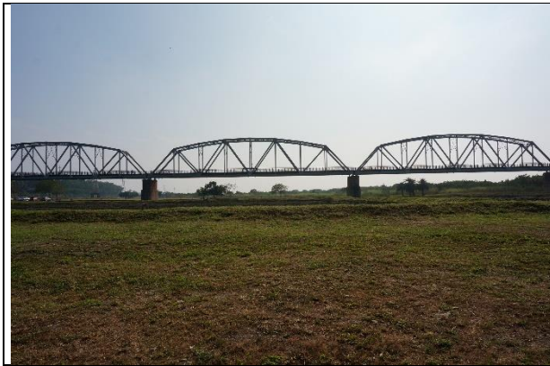
鐵路橋高屏溪西岸草生地
