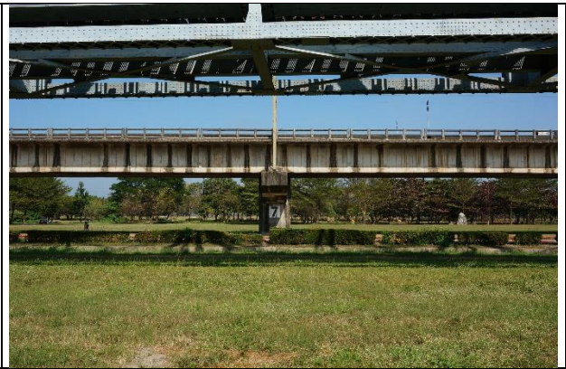
鐵路橋高屏溪西岸草生地
