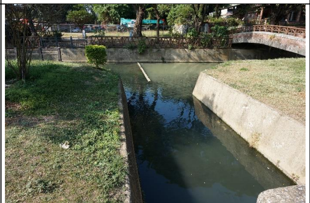
西岸排水溝渠環境
