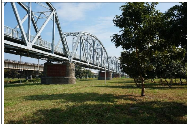
鐵路橋高屏溪西岸草生地
