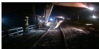
圖 11 曲線撥道整正（以挖土機協助撥道）
