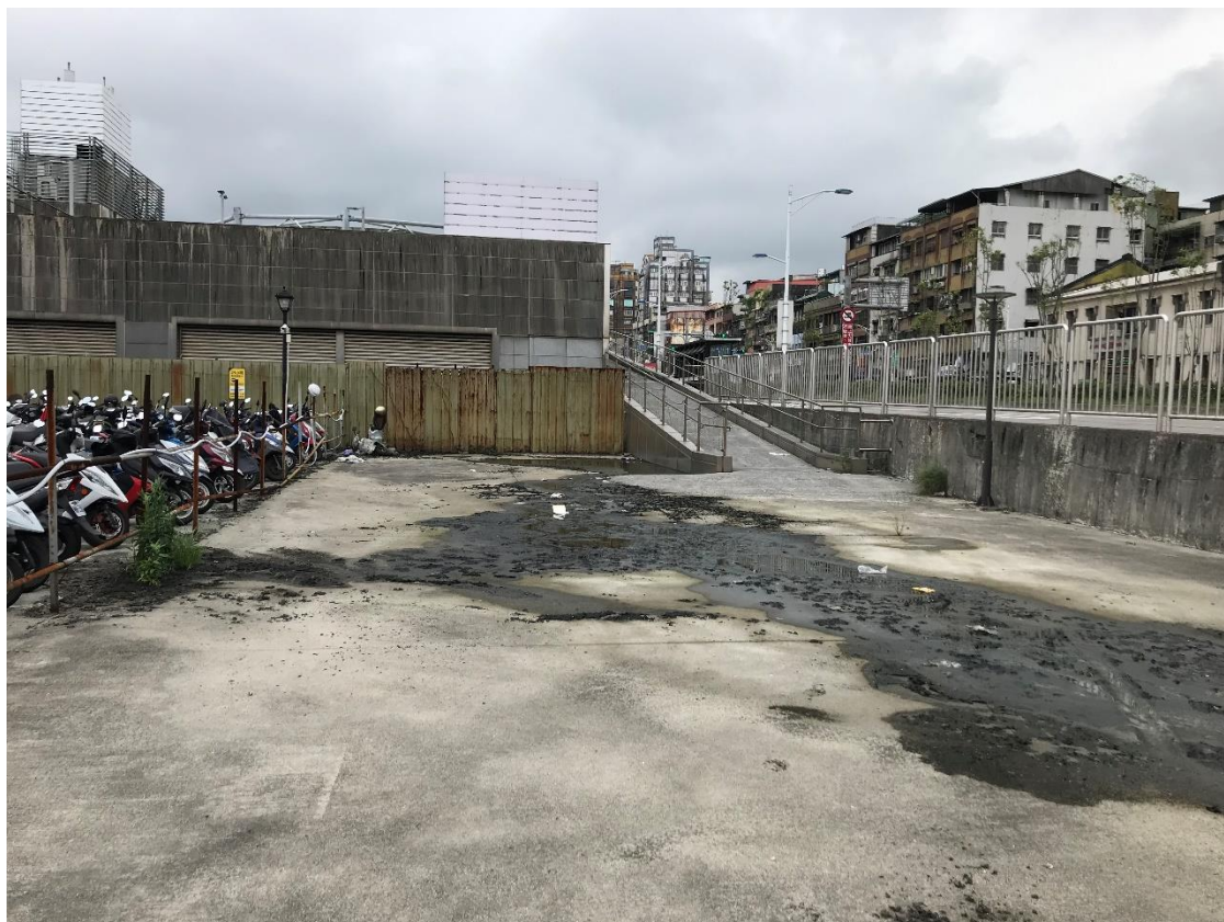
圖二、斜坡道下方新增區域
