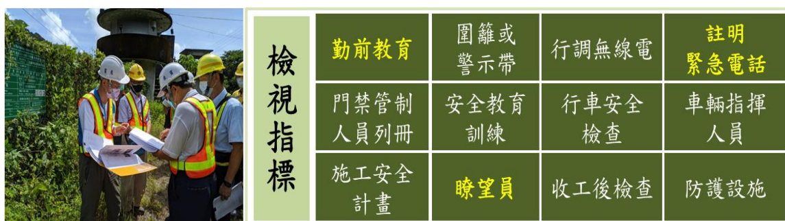
圖 1 臺鐵臨軌在建工程 12 項檢視項目
