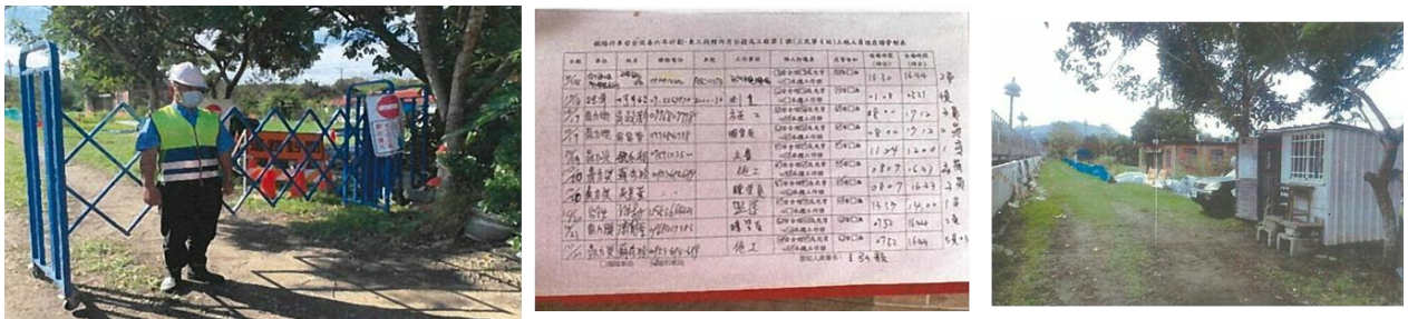
圖 3 臺鐵工地安全管理
