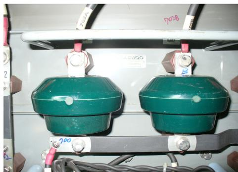
圖 5 突波抑制變阻器
