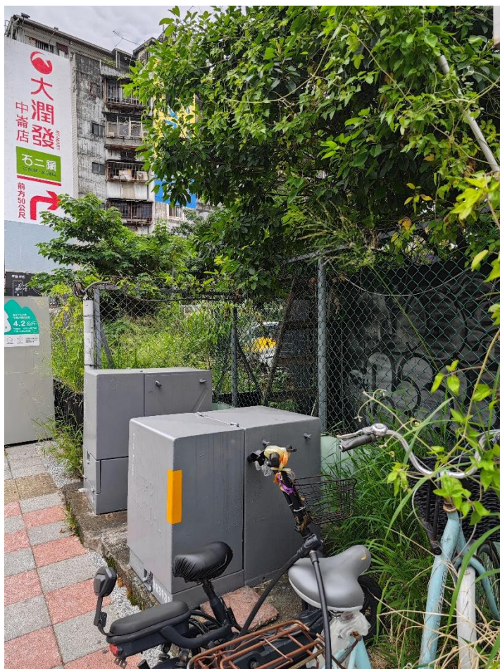
八德路二段一側，鐵圍籬 內範圍，為本案維管範圍
