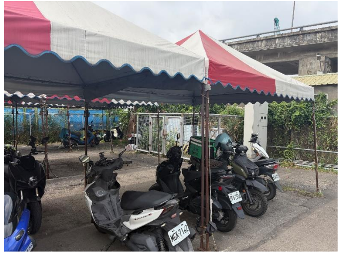
圖片二 台電電箱位置
