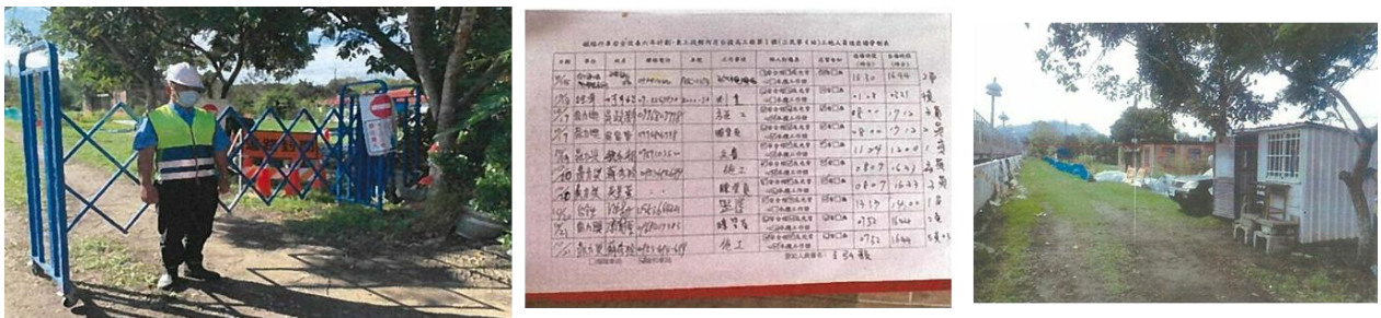
圖 3 臺鐵工地安全管理
