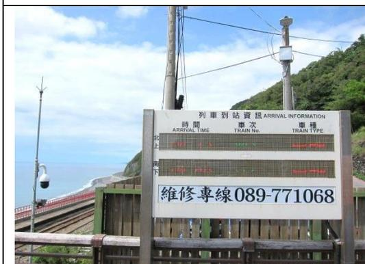
圖 19 多良站的列車資訊顯示系統(TIDS)
