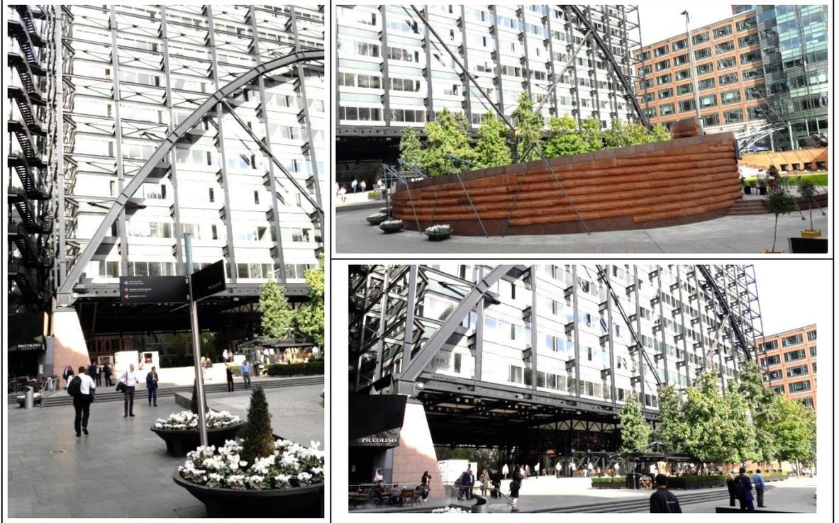
圖 14 利物浦街車站站後商辦大樓-鋼構懸吊設計
