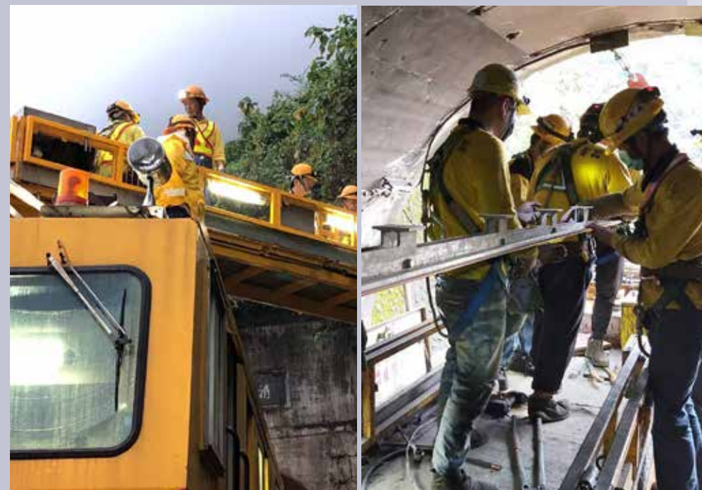
鐵軌修復過程
