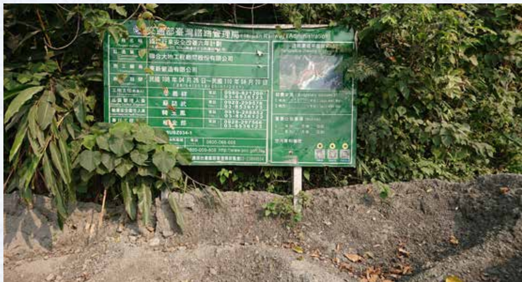
0402 事故發生於鐵路行車安全改善六年計畫 - 北迴線 K51+170~500 山側邊坡
