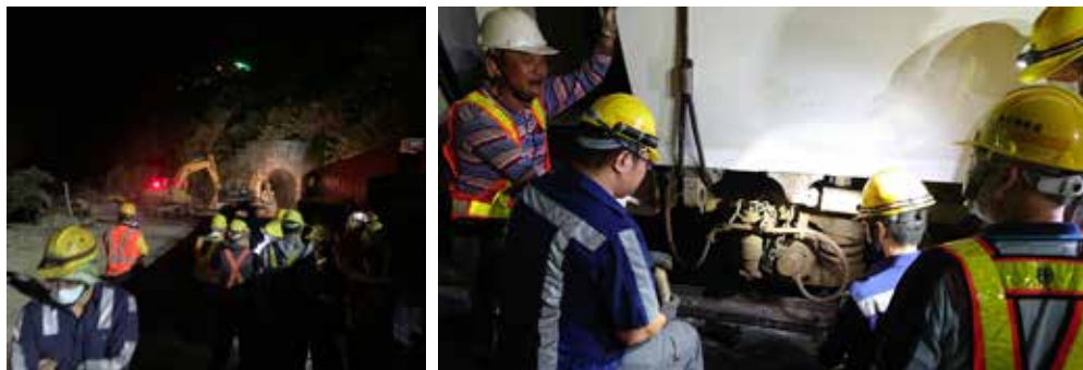
為能儘速通車，臺鐵人員徹夜搶修
