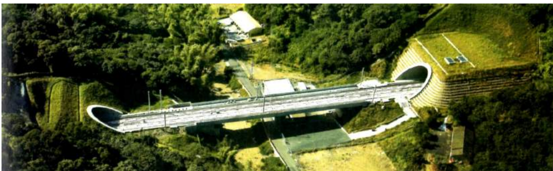
照片 3.3-5 台灣高鐵隧道正切式洞門（八卦山隧道南口附近）
