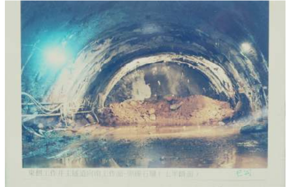
照片 6.4-4 隧道施工上半斷面開挖
