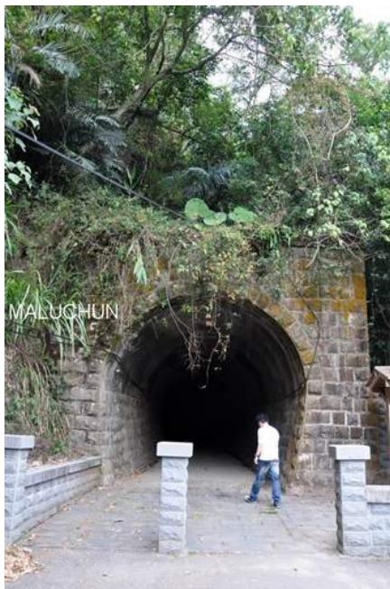
照片 4.2-3、照片 4.2-4 台灣早期的疊塊石與砌磚隧道（舊宜蘭線鐵路三爪子隧道西口）
