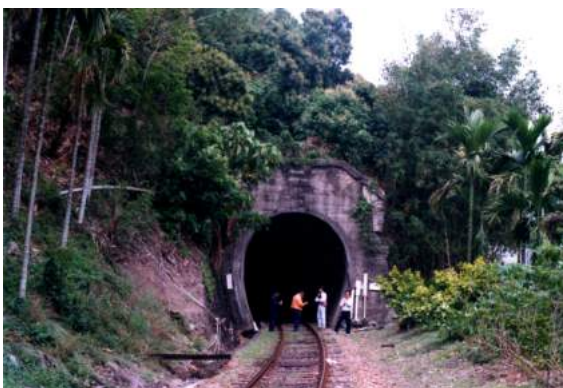
照片 5.3-7 台東線山里隧道群
