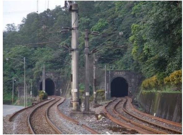
照片 5.4-6 宜蘭線五份隧道南口
