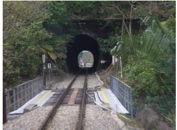
照片 5.7-14 集集支線 6 號隧道
