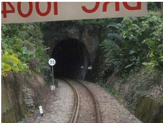
照片 5.7-9 集集支線 1 號隧道
