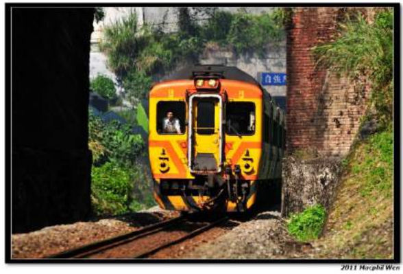
照片 5.3-4 自強隧道南口
