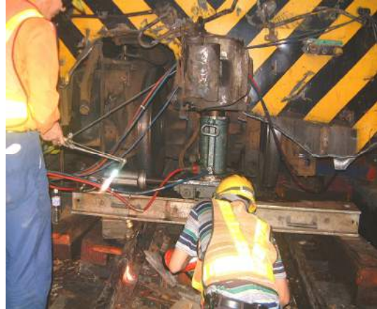
(照片 9-14) 734 次 R188 機車扶正後工務切斷鋼軌
