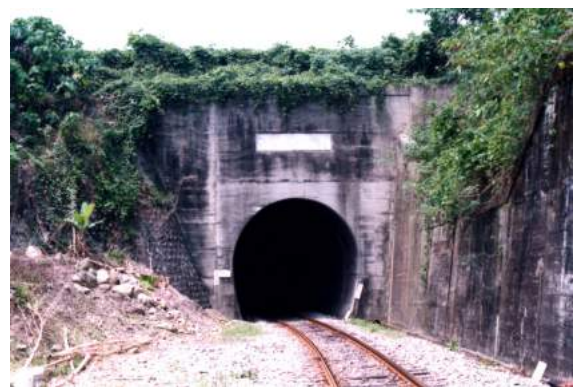
照片 5.3-6 台東線中興隧道
