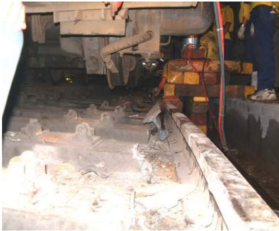
(照片 9-15) 機車扶正墊高後由工務取出損壞鋼軌
