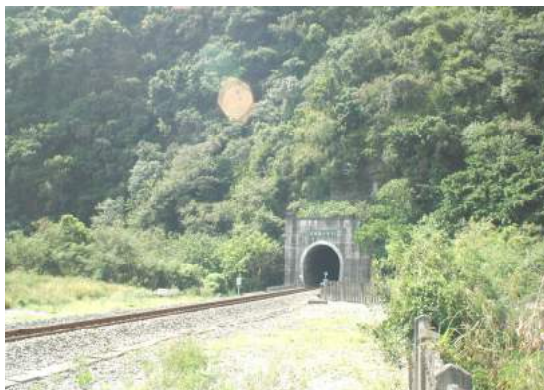
圖 5.6-15 大竹一號隧道北洞口
