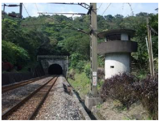
照片 5.4-16 宜蘭線合興隧道南口
