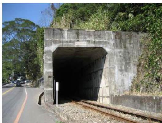
照片 5.7-3 內灣支線九芎坪隧道
