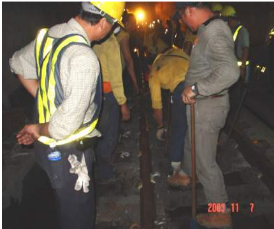
(照片 9-21) 工務辦理軌道鋪設復舊情形
