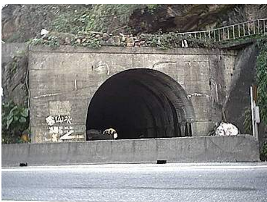
照片 5.7-16 深澳支線隧道
