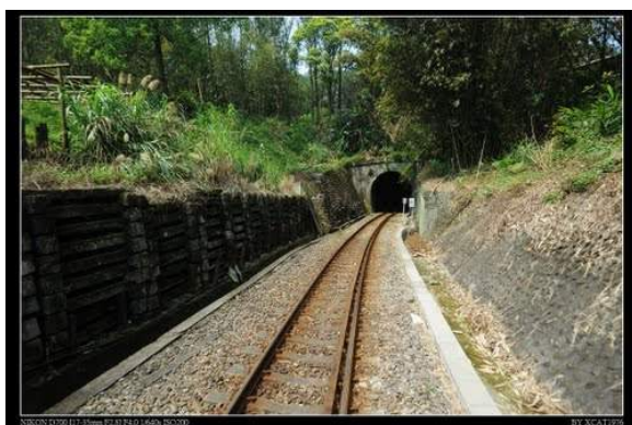
照片 5.7-1 內灣支線隧道
