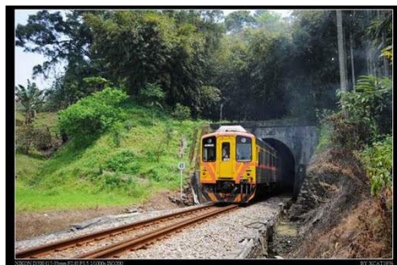
照片 5.7-2 內灣支線隧道
