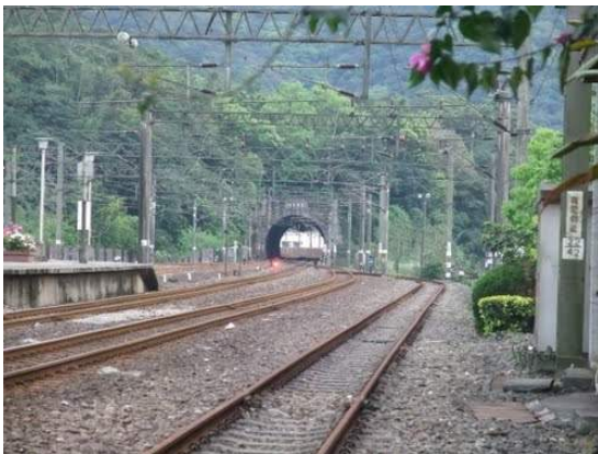
照片 5.4-9 宜蘭線雙溪隧道北口
