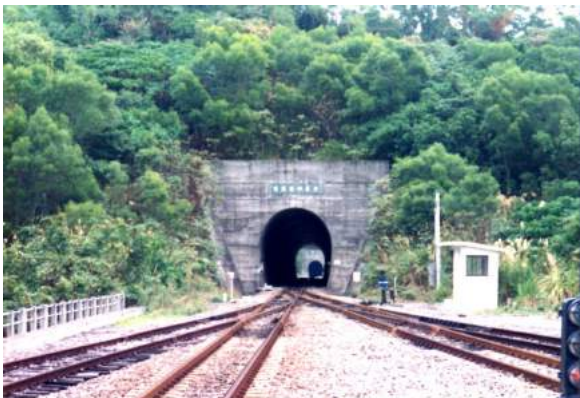
照片 5.6-3 古莊 4 號隧道北口
