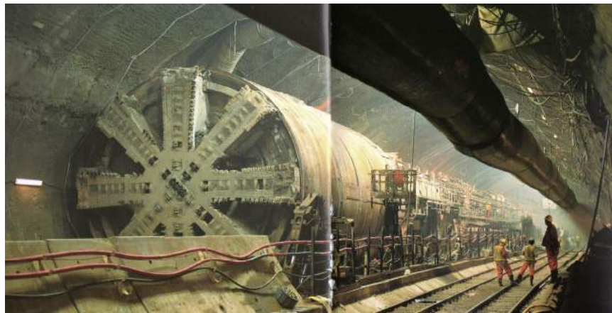
照片 4.1-1 英法海底隧道施工時之全斷面鑽掘機
