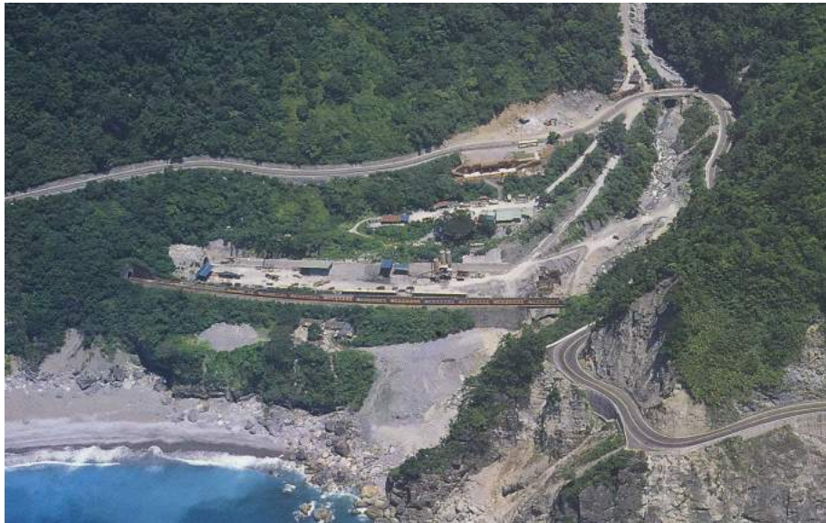
照片 5.5-3 北迴鐵路隧道
