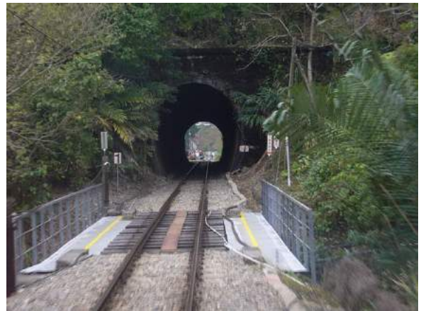
照片 5.7-14 集集支線 6 號隧道
