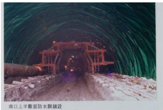
照片 6.4-5 隧道施工敷設防水膜
