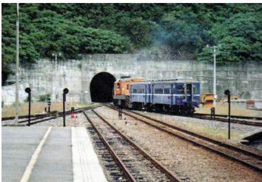
圖 5.6-7 大武 2 號隧道口
