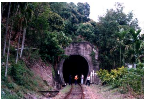
照片 5.3-7 台東線山里隧道群
