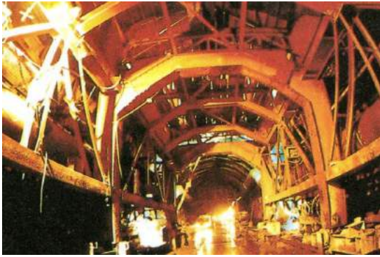
圖 5.6-1 南迴鐵路隧道施工
