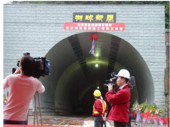
照片 5.1-6 新竹子嶺隧道（北口題字）
