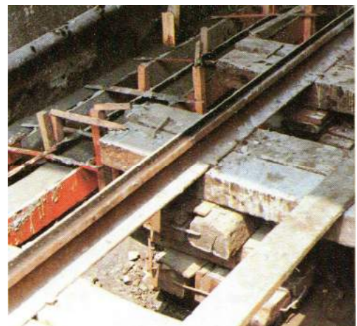
照片 3.2-6 台鐵隧道電化淨空改善工程
