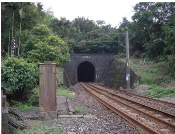
照片 5.4-7 宜蘭線五份隧道北口(東正線)
