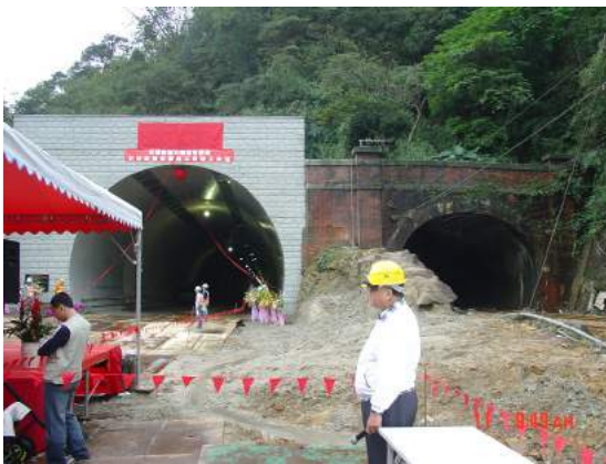
照片 5.1-5 竹子嶺隧道新舊並列
