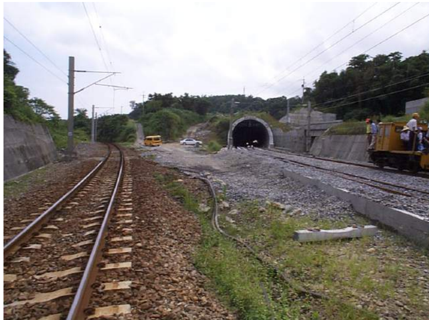
照片 5.2-6 苗栗隧道南口施工及舊線
