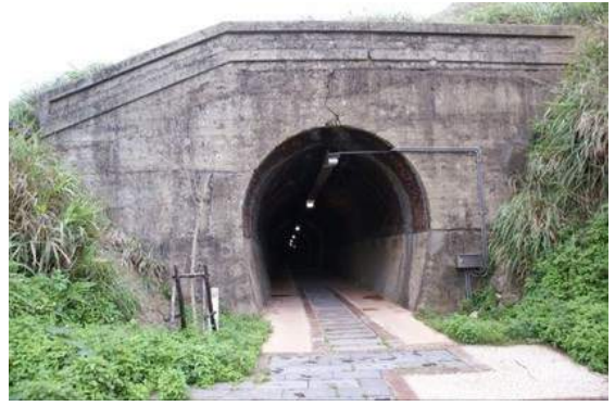
照片 5.2-4 後龍舊隧道
