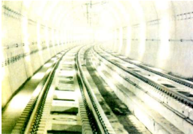
照片 4.2-5 預鑄環片襯砌與無碴軌道隧道
