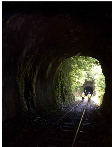
照片 5.7-6 平溪支線隧道
