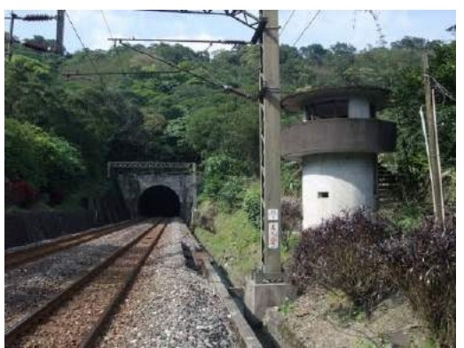
照片 5.4-16 宜蘭線合興隧道南口
