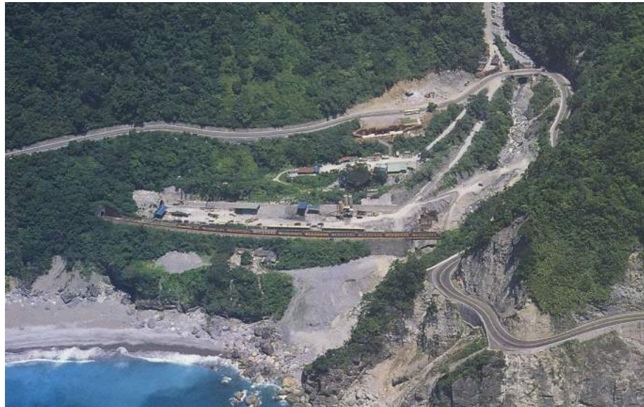
照片 5.5-3 北迴鐵路隧道
