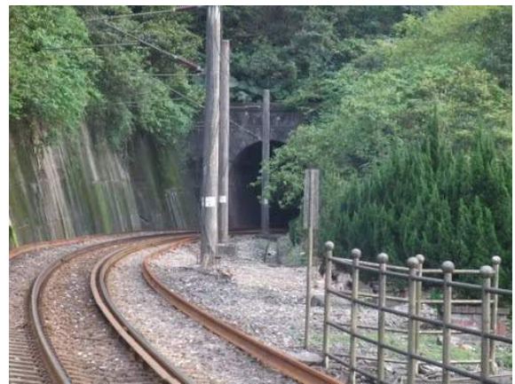
照片 5.4-8 宜蘭線五份隧道北口(西正線)
