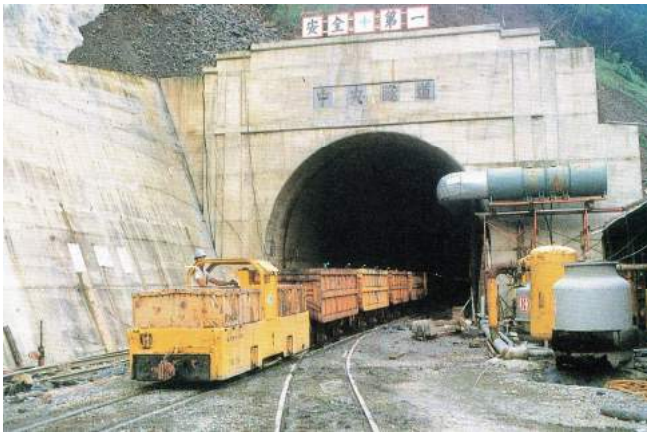
圖 5.6-3 中央隧道施工
