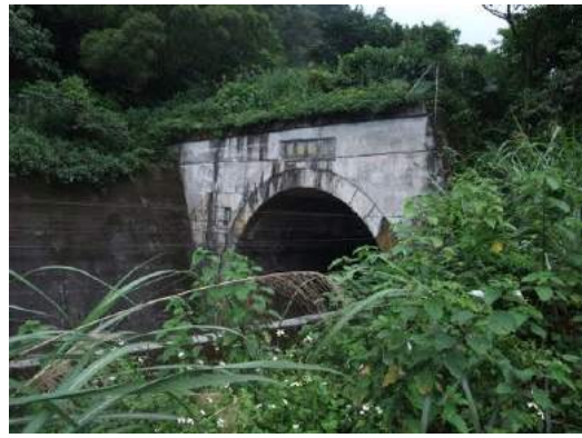
照片 5.4-12 宜蘭線更新隧道南口
