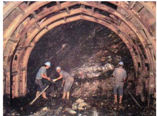
圖 5.6-4 南迴鐵路隧道施工
