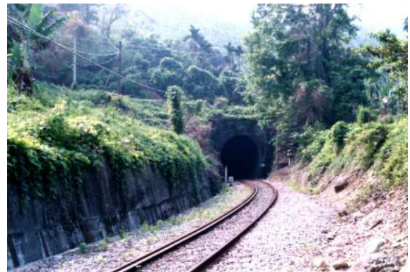
照片 5.3-8 台東線山里隧道群
