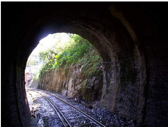
照片 5.7-5 平溪支線隧道
