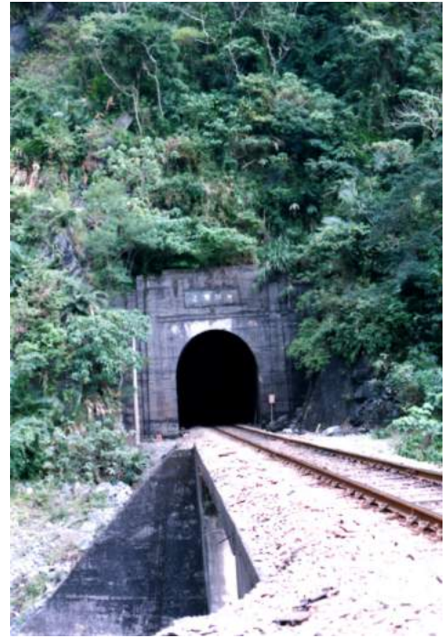
照片 5.5-5 北迴線和仁隧道
