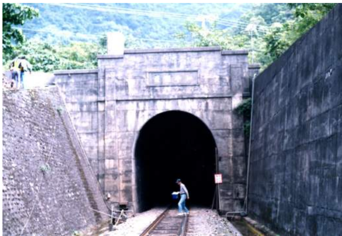
照片 5.5-6 北迴線和平隧道
