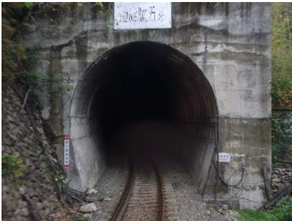
照片 5.7-13 集集支線 5 號隧道
