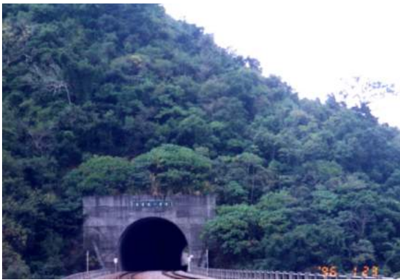
照片 5.6-1 古莊 1 號隧道北口
