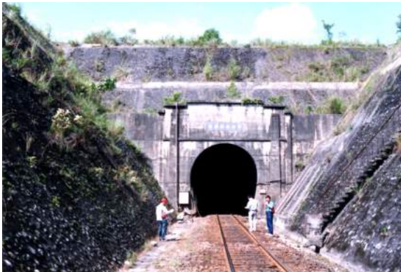
照片 5.3-5 台東線溪口 2 號隧道
