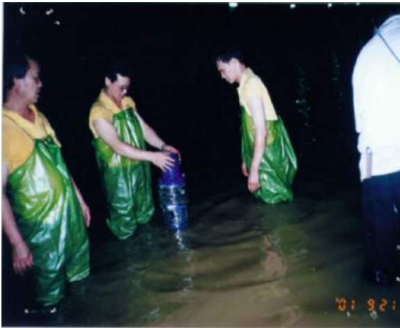
照片 7.2-1 隧道內緊急安裝抽水機配管配線抽水
