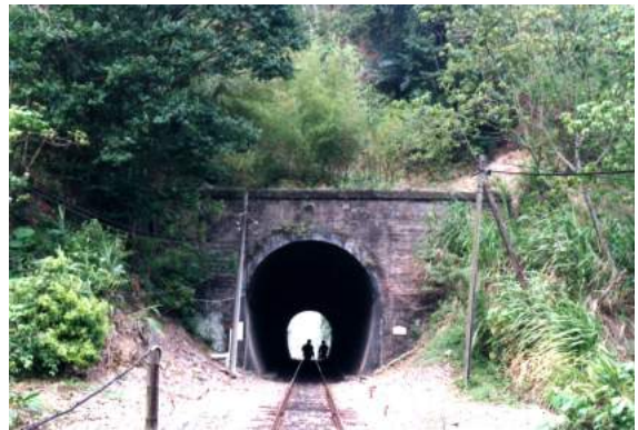
照片 5.3-8 台東線山里隧道群
