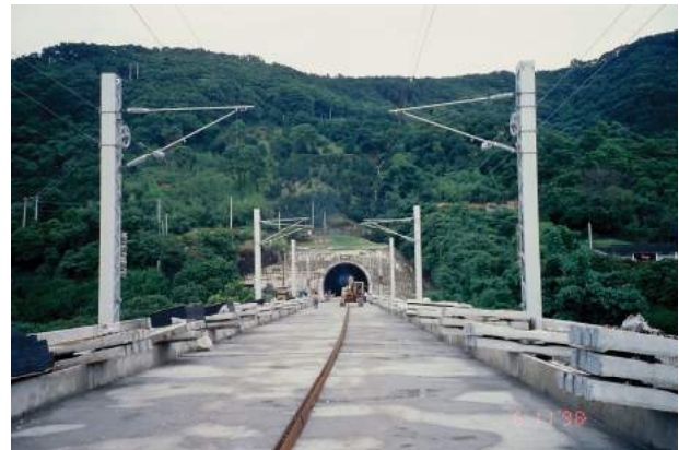
照片 6.4-10 三義隧道北口連接新鯉魚潭橋
