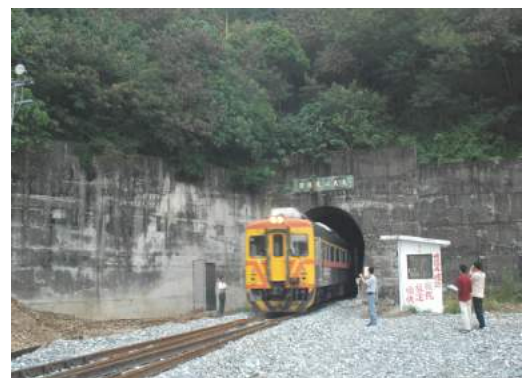
圖 5.6-22 大武二號隧道南洞口
