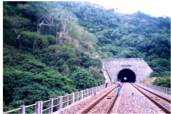
照片 5.6-2 古莊 3 號隧道北口
