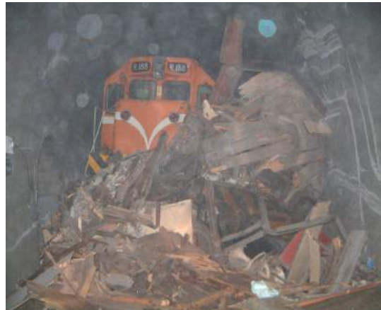
(照片 9-12) 896 次列車守車清除情形
