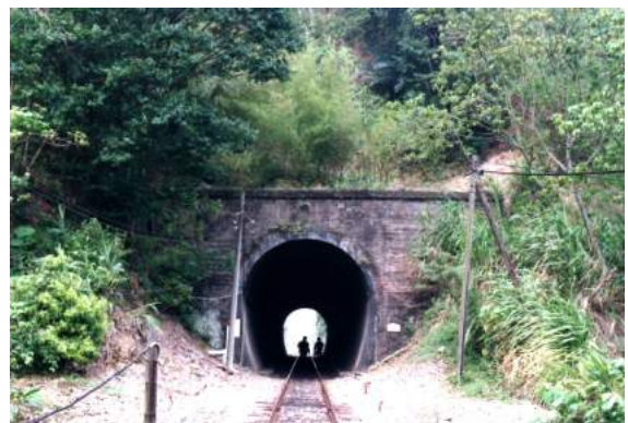
照片 5.3-8 台東線山里隧道群
