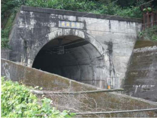
照片 5.4-11 宜蘭線更新隧道北口
