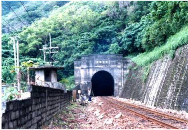
照片 5.5-4 北迴線和仁隧道
