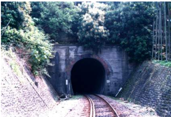
照片 5.3-7 台東線山里隧道群
