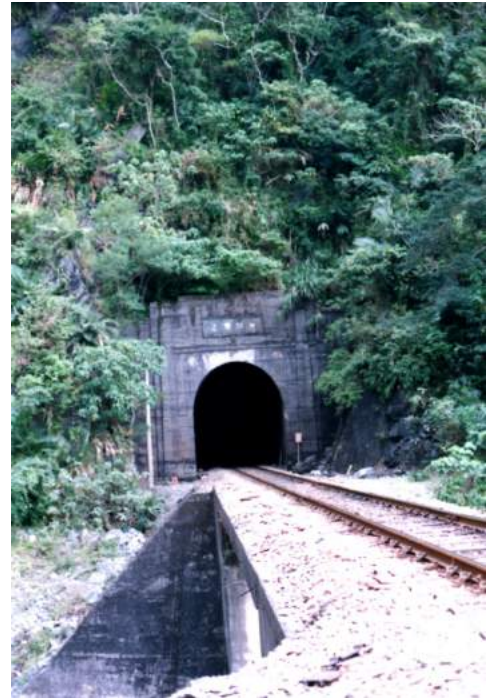
照片 5.5-5 北迴線和仁隧道
