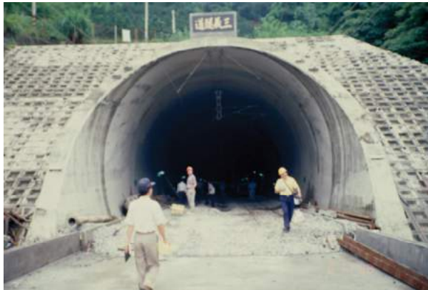
照片 6.4-9 三義隧道北洞口
