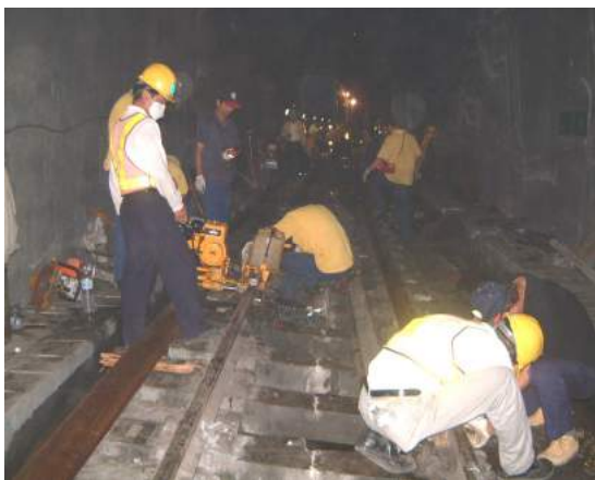
(照片 9-17) 工務辦理軌道舖設復舊情形
