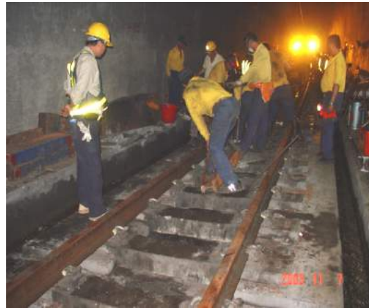
(照片 9-22) 工務辦理軌道鋪設復舊情形
