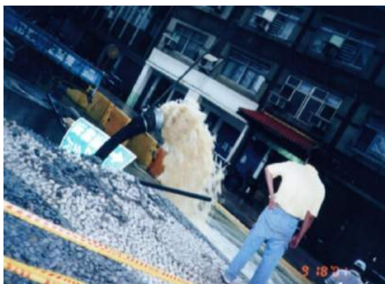
照片 7.2-3 安東街緊急出口處抽水現況
