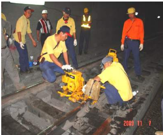
(照片 9-23) 工務辦理軌道鋪設復舊情形
