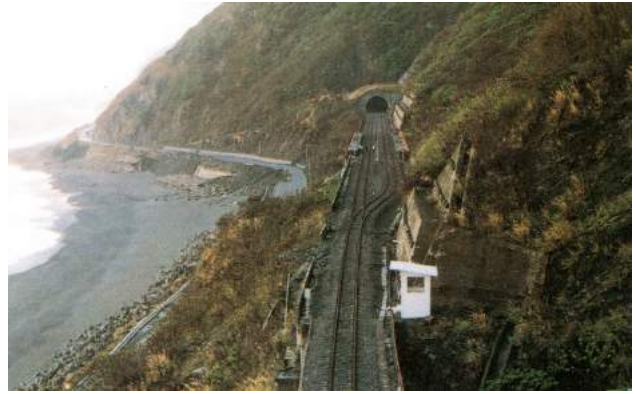
圖 5.6-2 南迴鐵路隧道
