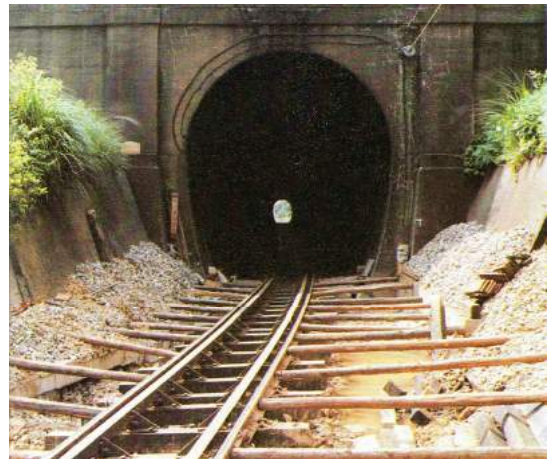
照片 3.2-2 台鐵隧道電化淨空改善工程
