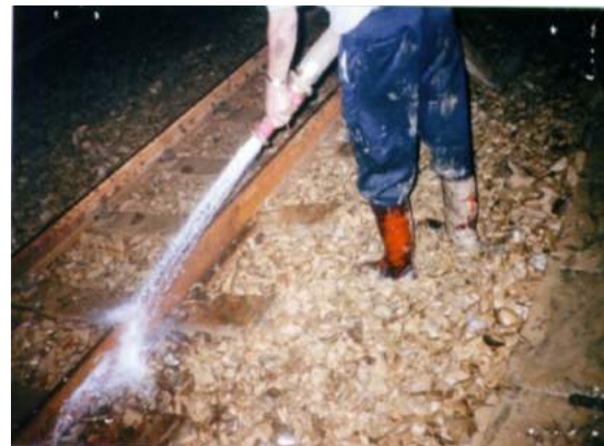
照片 7.2-4 軌道污泥清理
