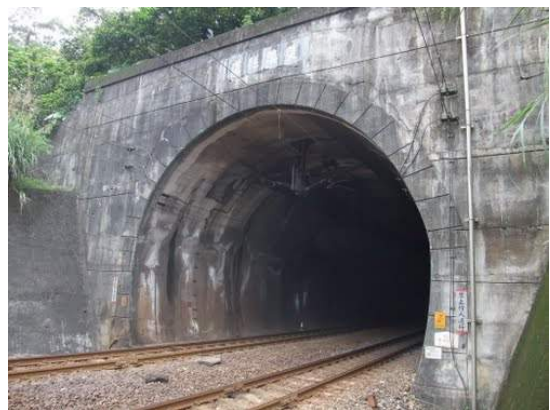
照片 5.4-10 宜蘭線雙溪隧道南口
