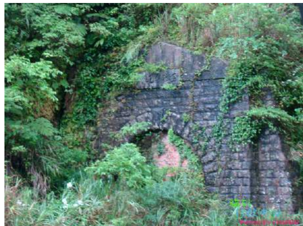
照片 4.2-3、照片 4.2-4 台灣早期的疊塊石與砌磚隧道（舊宜蘭線鐵路三爪子隧道西口）
