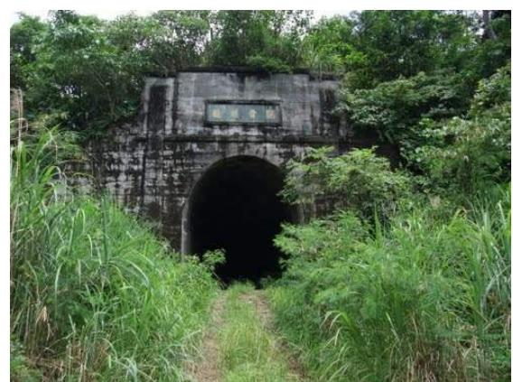
照片 5.5-5 北迴線舊觀音隧道北口
