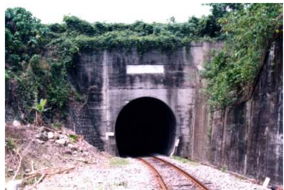
照片 5.3-6 台東線中興隧道
