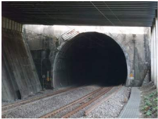
照片 5.4-14 宜蘭線更枋隧道南口
