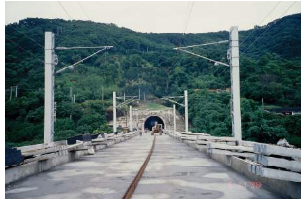
照片 6.4-10 三義隧道北口連接新鯉魚潭橋
