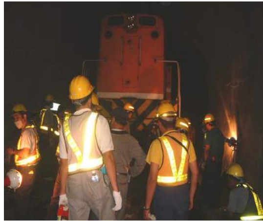
(照片 9-16) 工務鋪設臨時軌道情形
