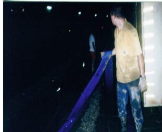
照片 7.2-2 隧道內緊急配置抽水管抽水
