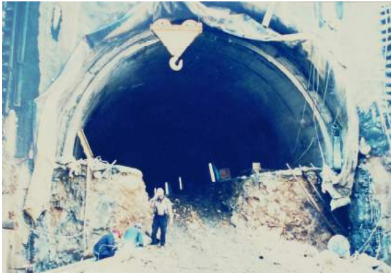
照片 6.4-1 主隧道施工
