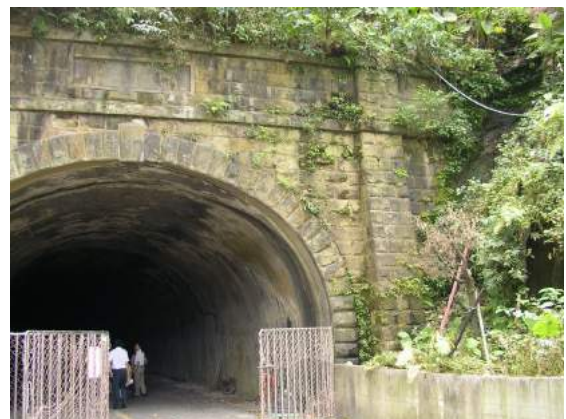
照片 5.7-17 基隆港支線仙洞隧道
