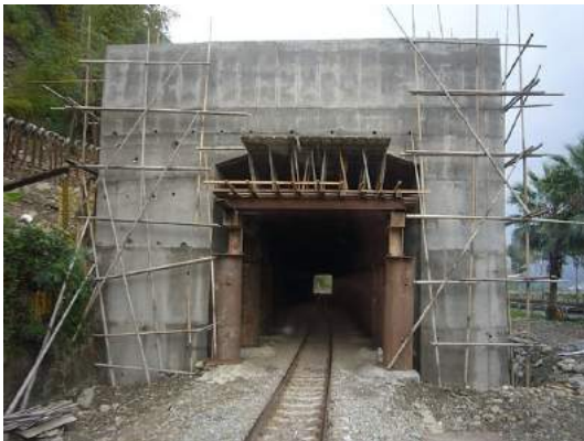
照片 5.7-14 集集支線明隧道
