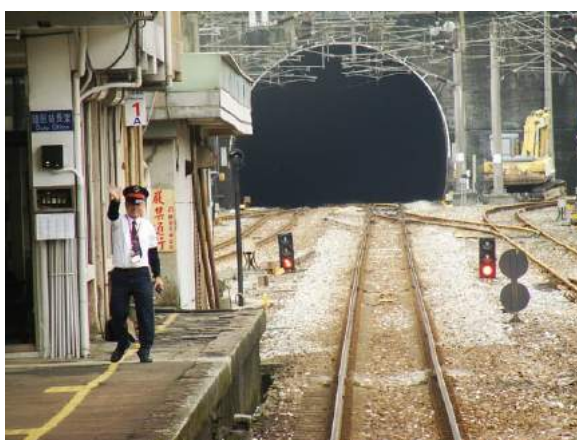
照片 5.4-3 宜蘭線示德隧道南口
