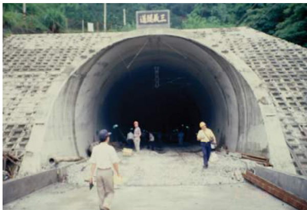
照片 6.4-9 三義隧道北洞口
