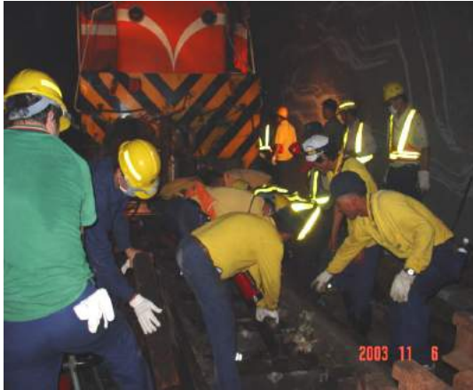
(照片 9-19) 工務辦理軌道鋪設復舊情形
