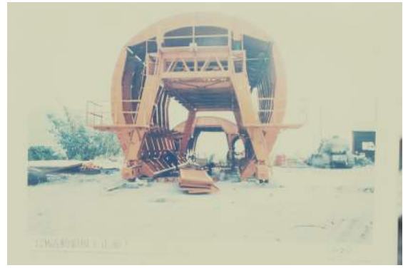
照片 6.4-8 隧道施工機械全斷面鋼模
