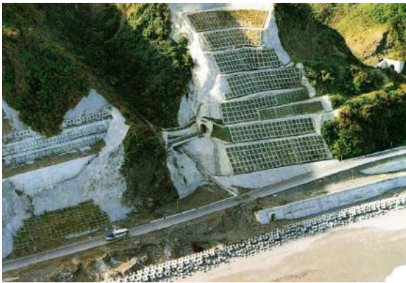
圖 5.6-5 大竹 4 號隧道口邊坡防護
