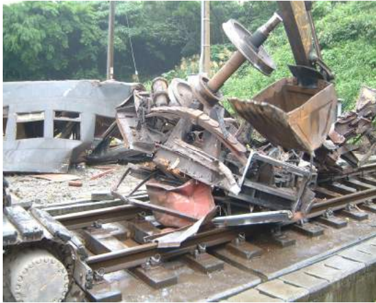
(照片 9-13) 896 次列車守車清除情形
