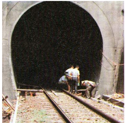
照片 3.2-4 台鐵隧道電化淨空改善工程
