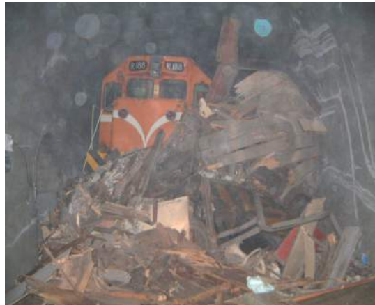
(照片 9-12) 896 次列車守車清除情形
