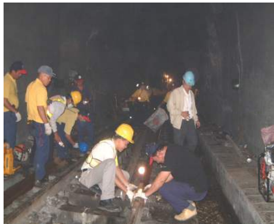
(照片 9-18) 工務辦理軌道鋪設復舊情形
