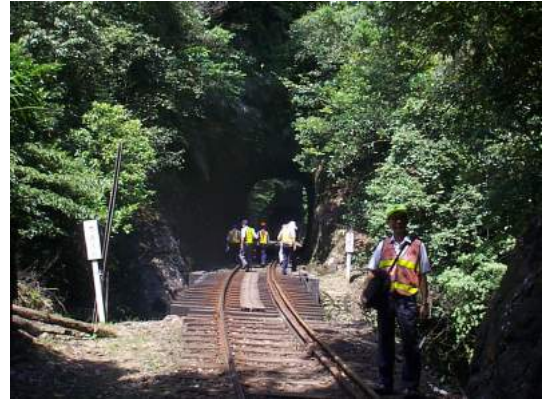
照片 5.7-8 平溪支線隧道
