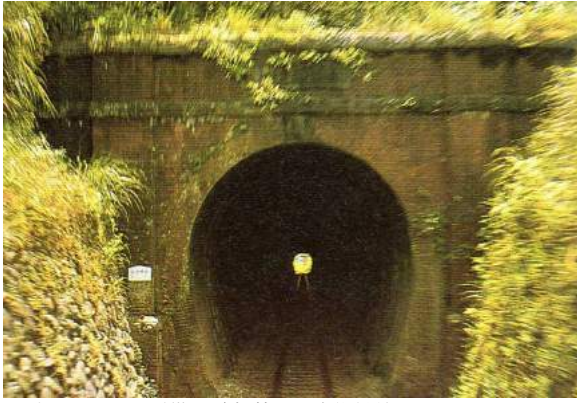
照片 5.1-11 縱貫線舊五堵隧道
