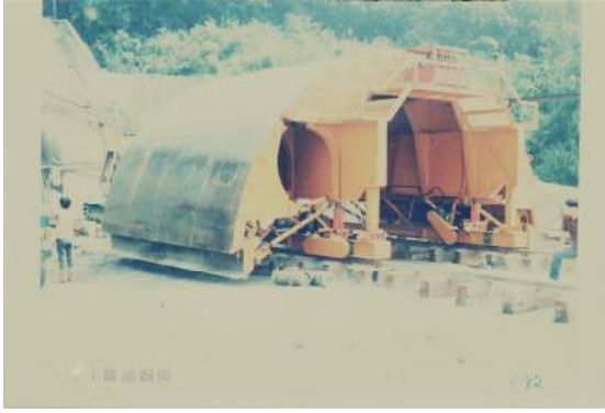
照片 6.4-7 隧道施工機械半斷面鋼模
