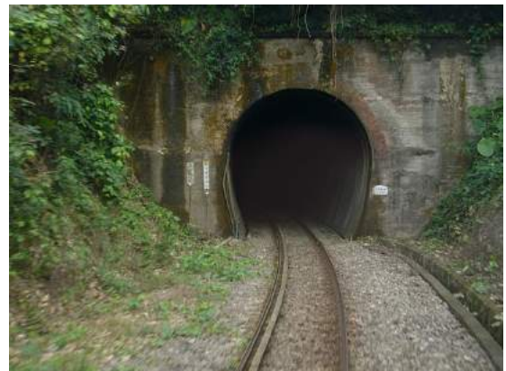
照片 5.7-10 集集支線 2 號隧道
