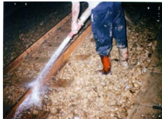
照片 7.2-4 軌道污泥清理
