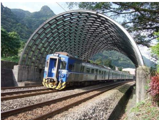
照片 5.4-17 宜蘭線合興隧道北口明洞式棚架
