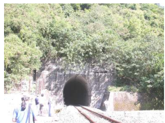
圖 5.6-14 大竹二號隧道南洞口
