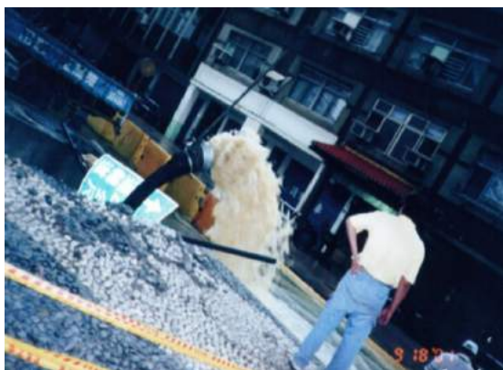
照片 7.2-3 安東街緊急出口處抽水現況
