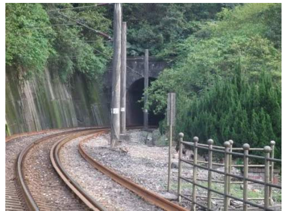
照片 5.4-8 宜蘭線五份隧道北口(西正線)
