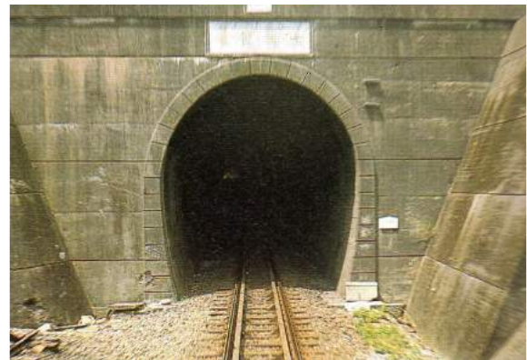
照片 5.1-10 縱貫線舊七堵隧道
