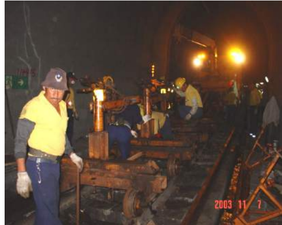
(照片 9-20) 工務辦理軌道鋪設復舊情形
