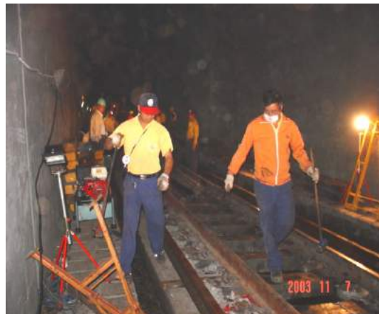
(照片 9-24) 工務辦理軌道鋪設復舊情形
