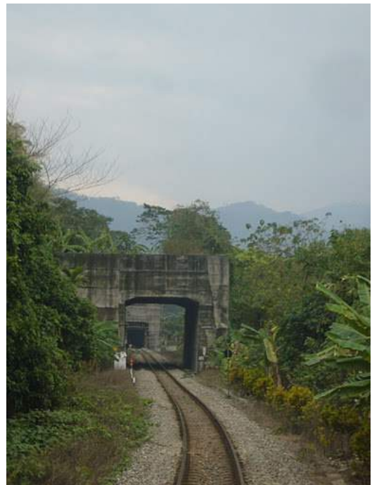
照片 5.7-15 集集支線明隧道
