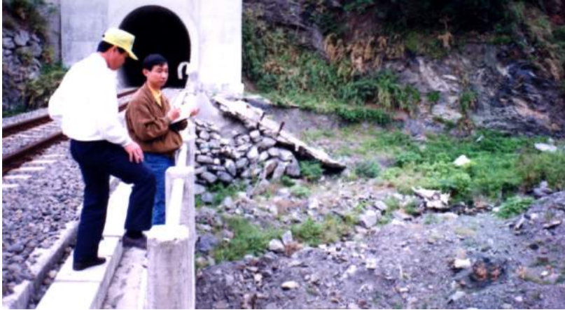
照片 7.1-4 南迴線大竹4號枋山隧道南口及多良1號橋台邊坡坍塌
