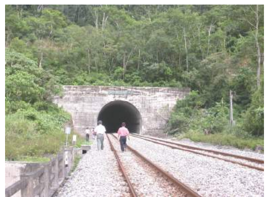
圖 5.6-24 安朔隧道南洞口
