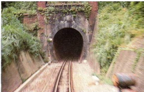
照片 5.2-1 舊山線苗栗隧道
