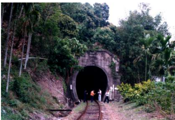
照片 5.3-7 台東線山里隧道群
