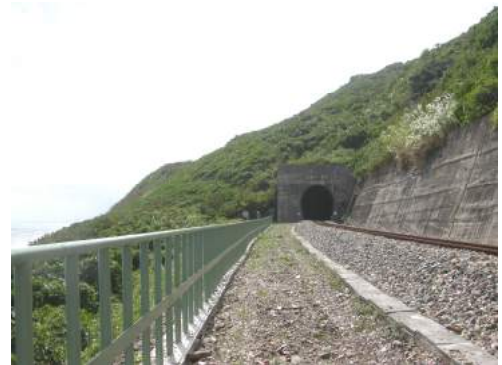
圖 5.6-20 大武二號隧道北洞口
