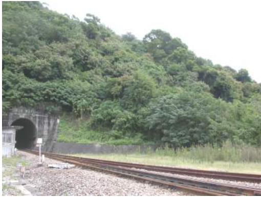
圖 5.6-9 金崙隧道南洞口
