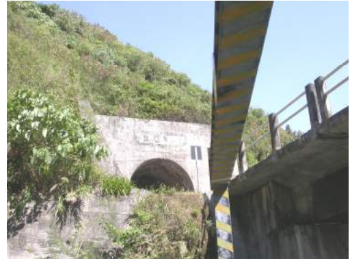
圖 5.6-12 多良一號隧道南洞口
