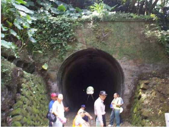
照片 5.7-7 平溪支線隧道
