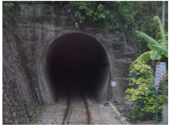
照片 5.7-12 集集支線 4 號隧道
