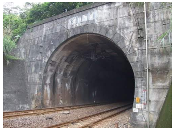
照片 5.4-10 宜蘭線雙溪隧道南口
