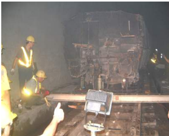
(照片 9-11) 896 次石灰石斗車搶修情形
