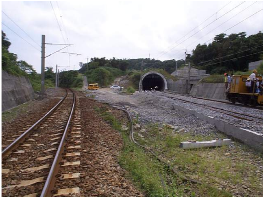
照片 5.2-6 苗栗隧道南口施工及舊線
