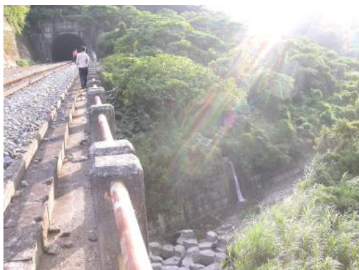
圖 5.6-23 安朔隧道北洞口
