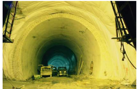
照片 6.4-6 隧道施工襯砌
