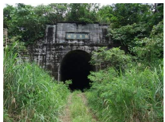
照片 5.5-5 北迴線舊觀音隧道北口
