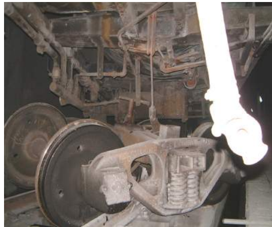
(照片 9-10) 734 次散裝水泥車出軌情形
