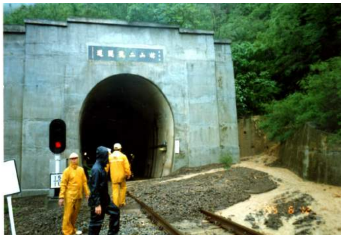
照片 7.1-3 南迴線枋山隧道口災害
