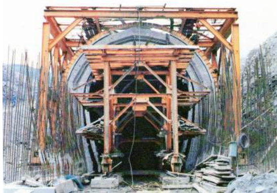
照片 5.3-1 光復河底隧道施工
