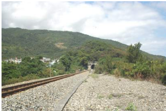
圖 5.6-19 大鳥隧道南洞口
