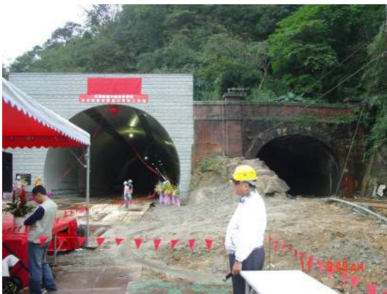
照片 5.1-5 竹子嶺隧道新舊並列
