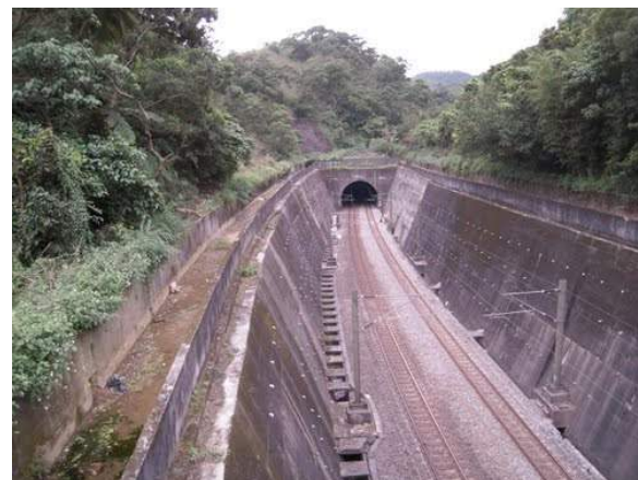
照片 5.4-4 宜蘭線外澳隧道北口
