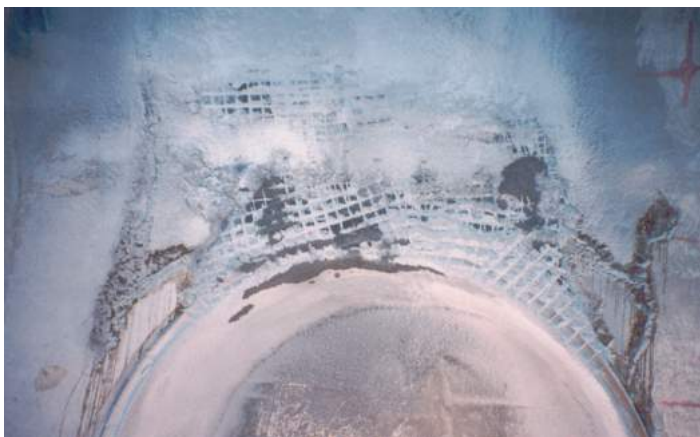
照片 7.5-2 三義壹號隧道受損襯砌掛網噴凝土補強
