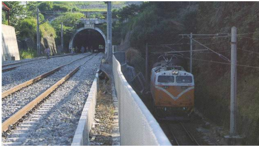
照片 5.2-5 苗栗站北新舊山線苗南隧道
