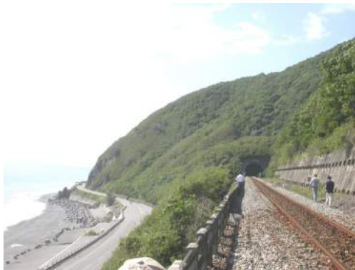
圖 5.6-11 多良一號隧道北洞口
