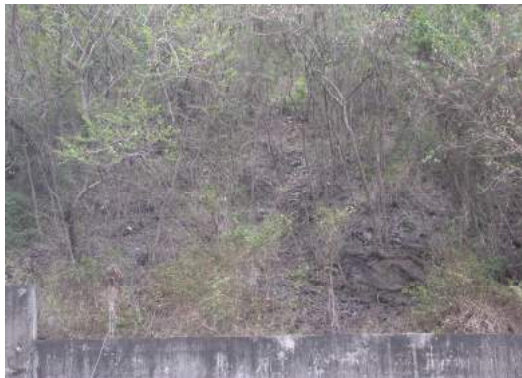
圖 5.6-21 大武二號隧道南洞口覆蓋層
