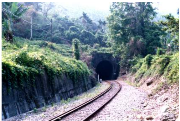
照片 5.3-8 台東線山里隧道群
