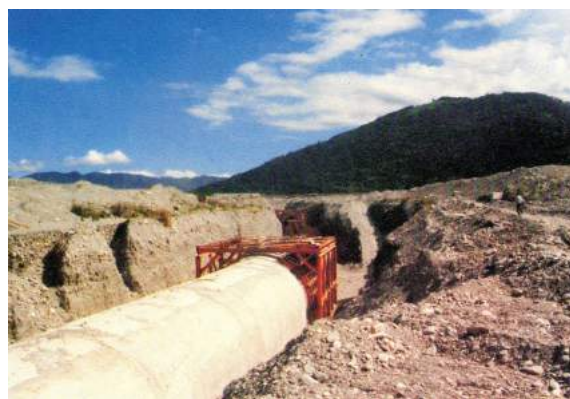
照片 5.3-2 光復河底隧道施工
