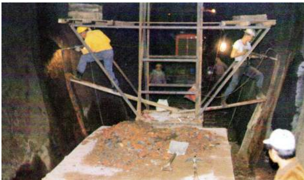
照片 3.2-3 台鐵隧道電化淨空改善工程
