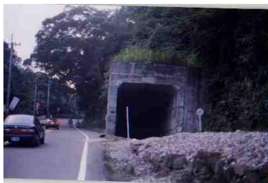
照片 5.7-4 內灣支線九芎坪隧道
