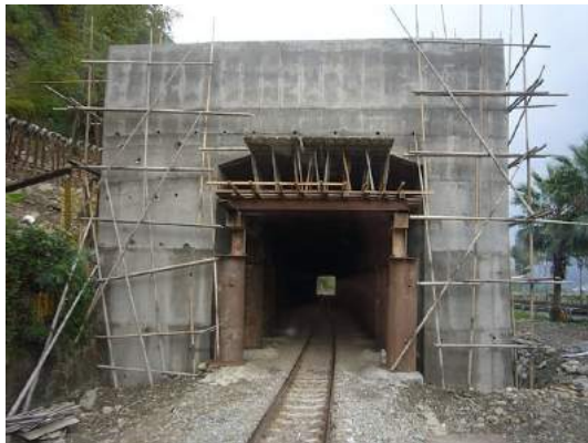
照片 5.7-14 集集支線明隧道
