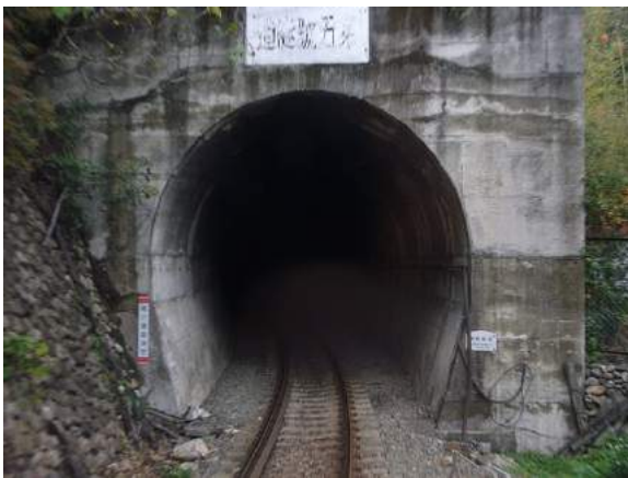
照片 5.7-13 集集支線 5 號隧道
