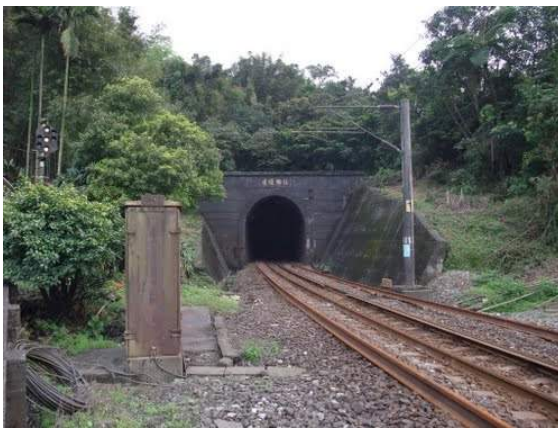
照片 5.4-7 宜蘭線五份隧道北口(東正線)
