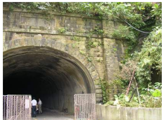
照片 5.7-17 基隆港支線仙洞隧道
