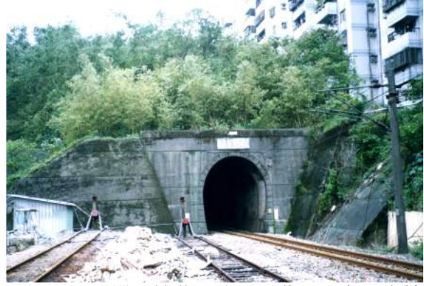
照片 5.1-12 縱貫線舊七堵隧道北口及右側高樓
