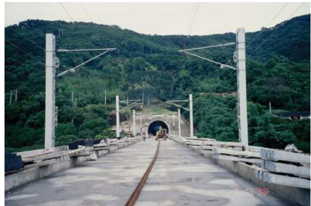
照片 6.4-10 三義隧道北口連接新鯉魚潭橋
