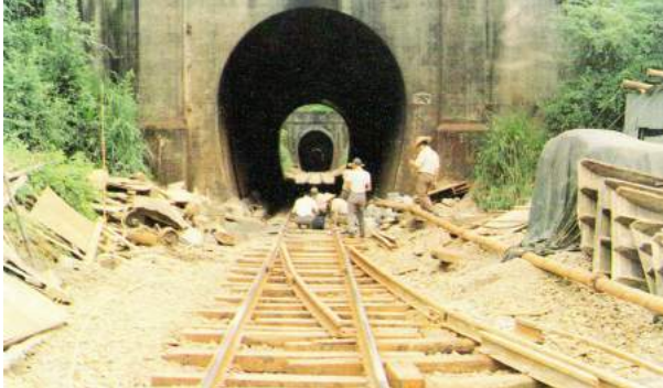
照片 3.2-1 台鐵隧道電化淨空改善工程
