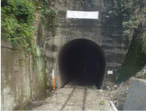
照片 5.7-11 集集支線中興隧道
