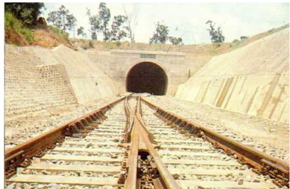
照片 5.2-2 新銅鑼隧道
