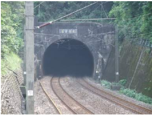
照片 5.4-13 宜蘭線更枋隧道北口
