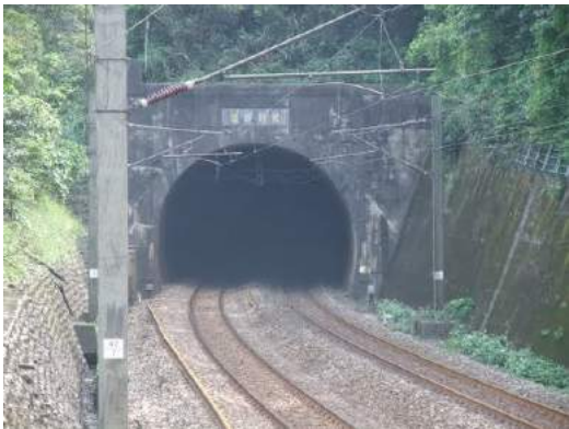
照片 5.4-13 宜蘭線更枋隧道北口
