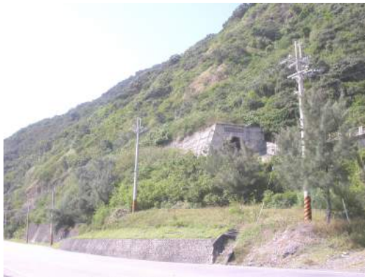
圖 5.6-13 大竹二號隧道北洞口
