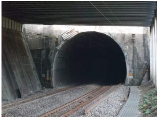
照片 5.4-14 宜蘭線更枋隧道南口
