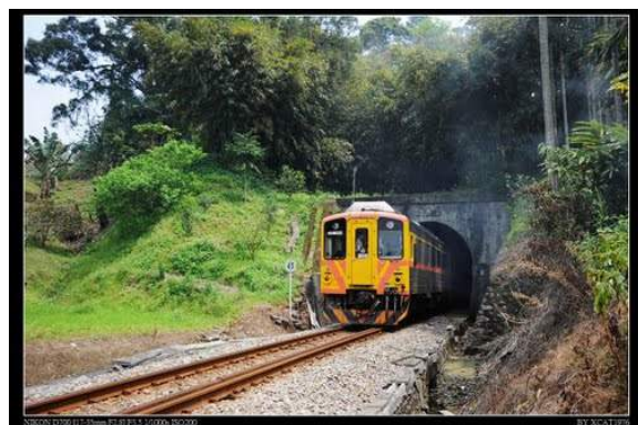
照片 5.7-2 內灣支線隧道
