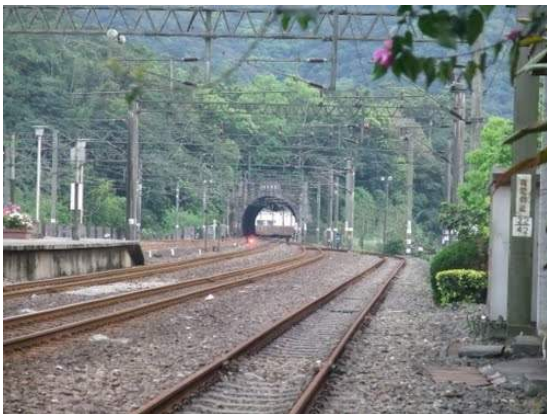
照片 5.4-9 宜蘭線雙溪隧道北口
