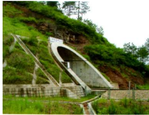
照片 3.3-2 正切式洞門
