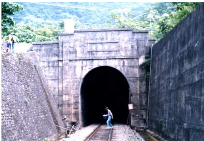
照片 5.5-6 北迴線和平隧道
