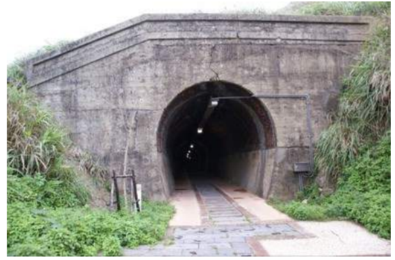
照片 5.2-4 後龍舊隧道
