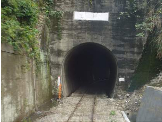
照片 5.7-11 集集支線中興隧道
