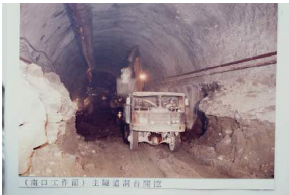
照片 6.4-3 隧道施工下半斷面開挖
