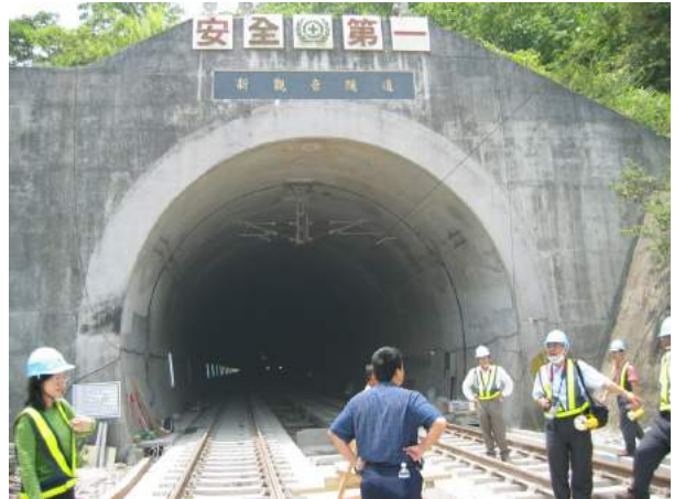
照片 5.5-2 新觀音隧道
