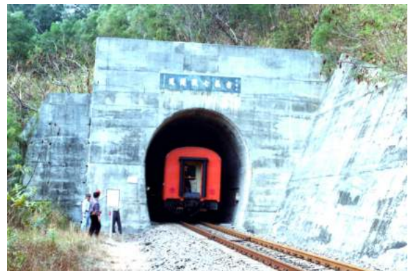
照片 5.6-4 古莊 7 號隧道口
