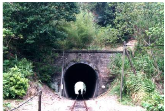
照片 5.3-8 台東線山里隧道群
